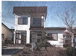
佐藤工務店が0円物件で入手した1戸建て。表は何もないようだが、裏に回ると雪の重みで屋根の一部が壊れている
