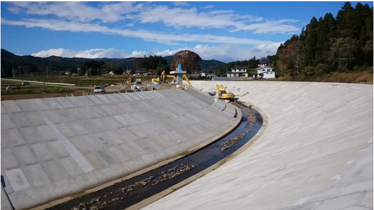
写真3「沖ノ田川の護岸工事」 = 2016年11月、著者撮影
