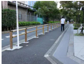
東京都森林組合が手掛けた多摩産材製ガードレール (東京・新宿)
